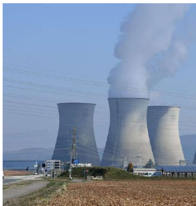
Centrale nucléaire du Bugey - Source : France Bleu
