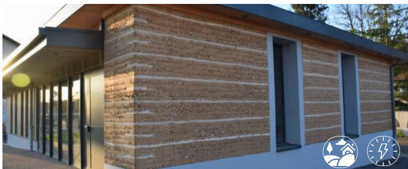
Nouvelles constructions en pisé
