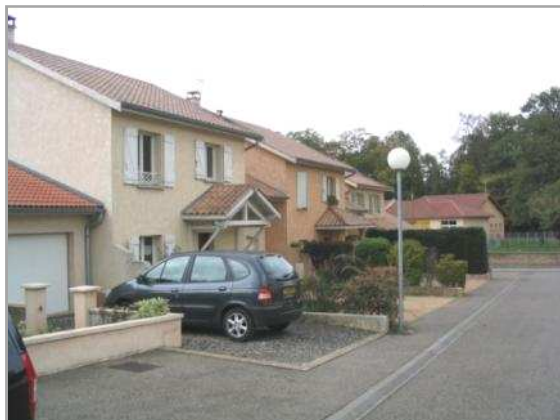
Opération récente de maisons de ville à Fareins
