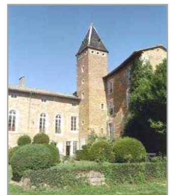
Château de la Bâtie
